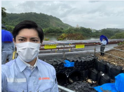
登米市県道東和薄衣線の復旧現場視察
