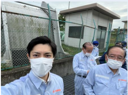
美里町笹館地区ポンプ場の視察
