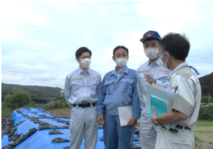
↑建設企業委員会で豪雨被害の復旧現場(出来川)を視察。
